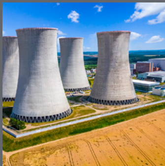
Jaderná elektrárna Dukovany
