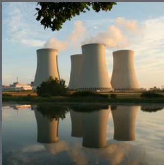
Jaderná elektrárna Temelín
