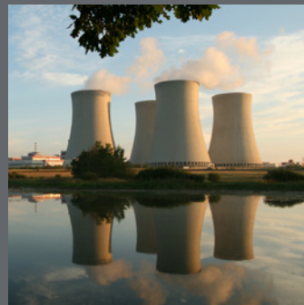
Jaderná elektrárna Temelín
