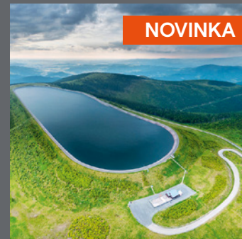
Přečerpávací elektrárna Dlouhé stráně
