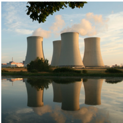
Jaderná elektrárna Temelín
