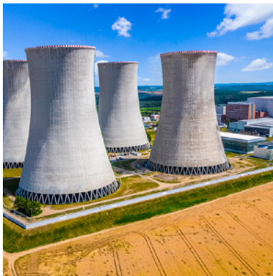
Jaderná elektrárna Dukovany
